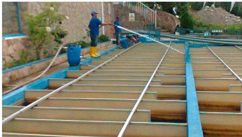
Figura 4 Limpieza de la sección de floculación
