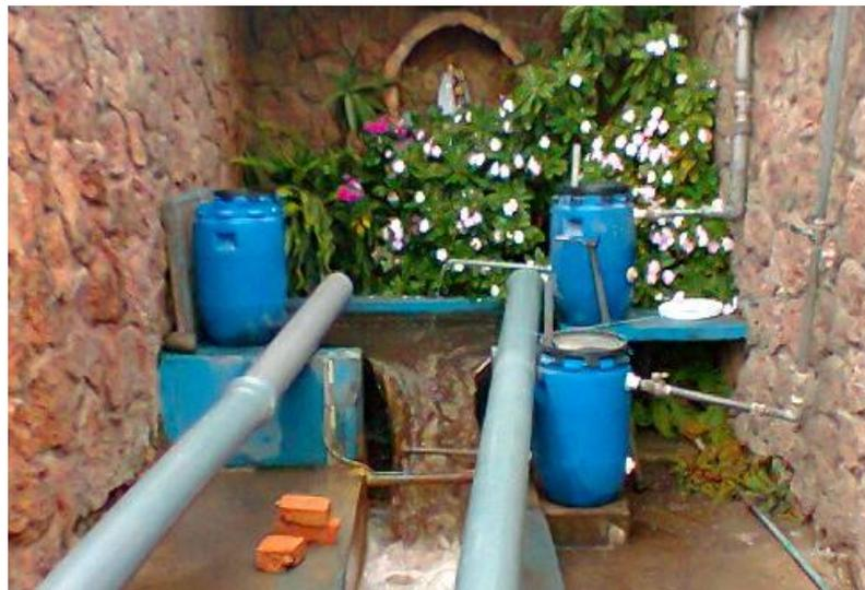
Figura 3 Mezcla rápida y adición de químicos
