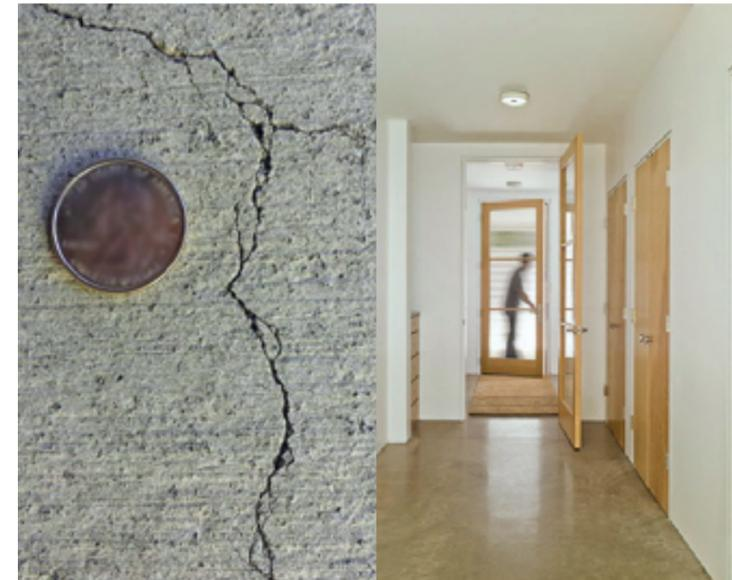
Estos tipos de grietas surgen de forma natural debido a las propiedades físicas del hormigón, los mismos que tienen elementos que deben ser manejados con equidad durante su preparación. Dentro de estos elementos tenemos: cemento, arena, piedra pequeña y agua más aditivos, estos elementos son mezclados mediante un orden de preparación.
