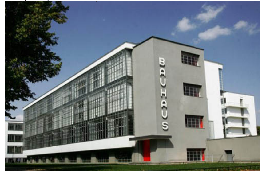
Imagen 15: Bauhaus, vista exterior
