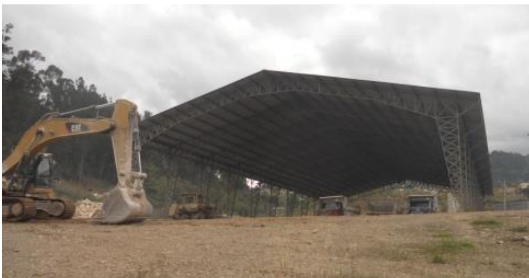
Figura 1.8 Canchón de almacenamiento de clinker.
