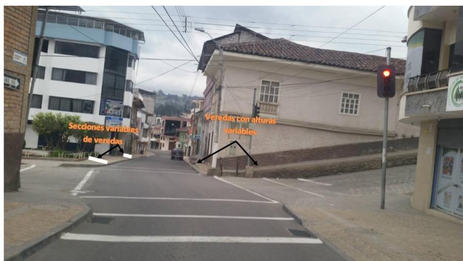
**Figura 3.22** Sección de vereda variable.
