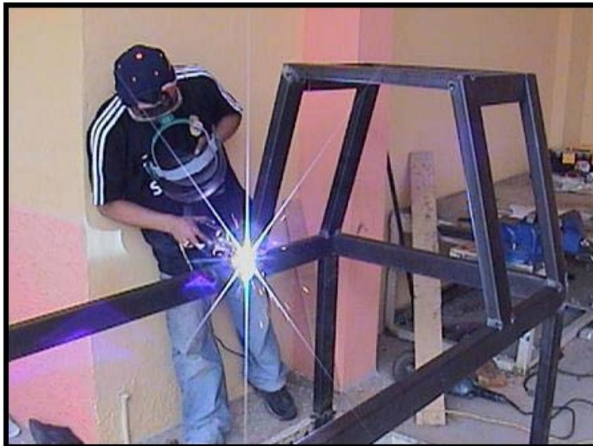
**Foto 9. Construcción de las bases de sujeción**
