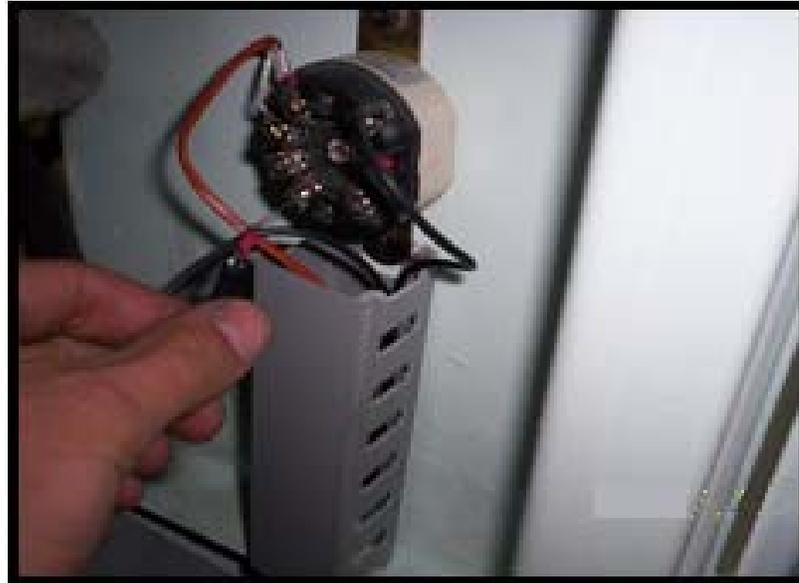
La termocupla (**Fig.137**), está ubicada en el tanque de combustible y mide la temperatura del líquido enviando señales de 4 a 20 mA; las mismas que son recibidas por el transmisor (**Fig. 138**), el cual las transforma en señales de tipo analógicas que a su vez son recibidas por el módulo analógico del PLC e introducidas como variables en su programa, a través del cual activa o desactiva a las niquelinas según la temperatura del líquido de pruebas.
