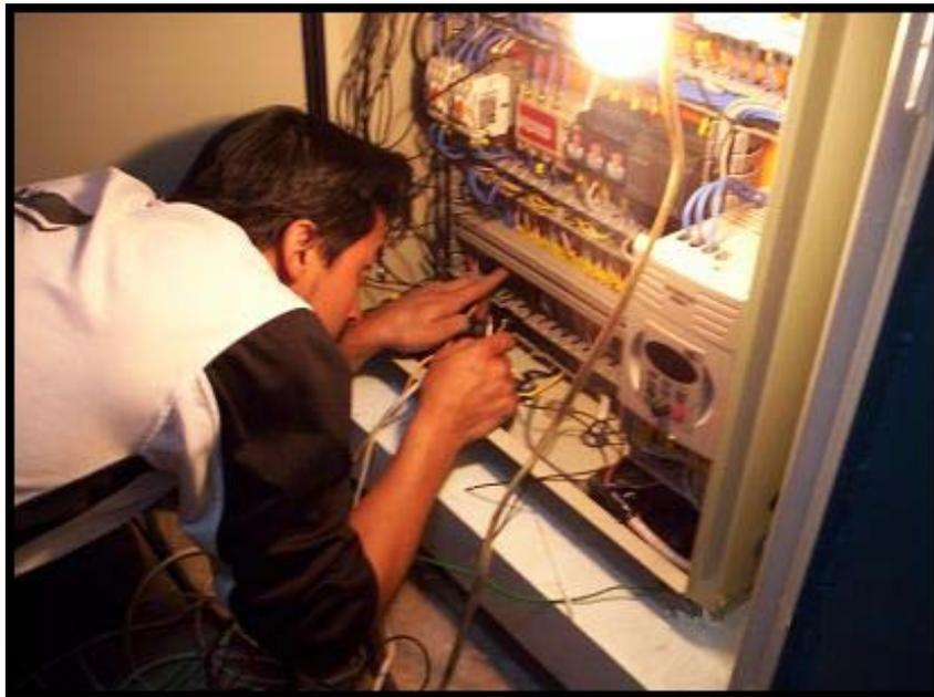
**Foto 24. Programación de los elementos electrónicos del banco**
