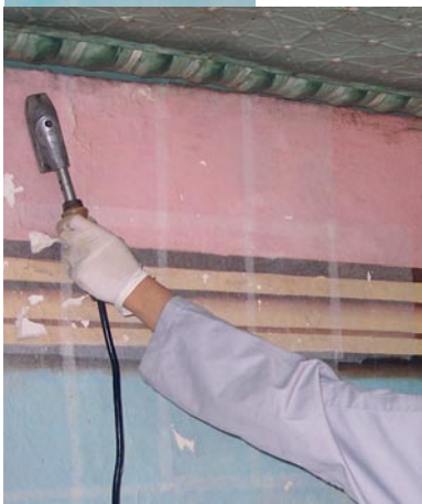
Consolidación con plancha
