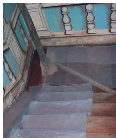
Colocación de plásticos
