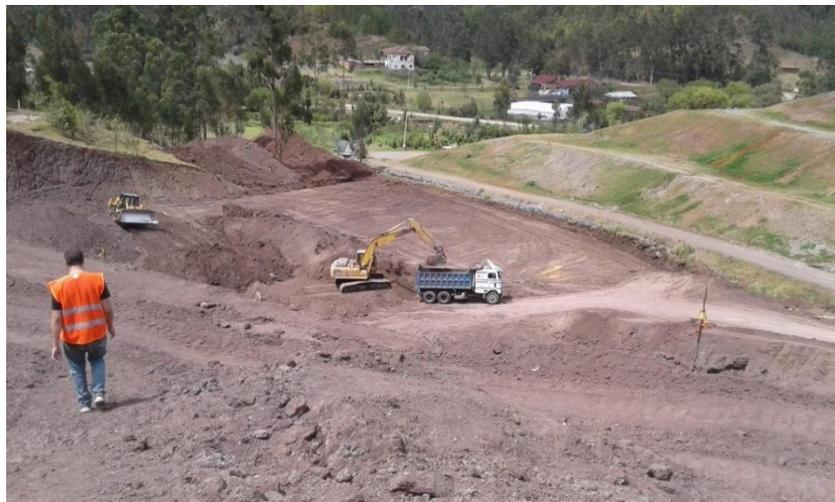
Figura 4.1. Explotación de suelo rojo para capa de cobertura de los desechos sólidos.
