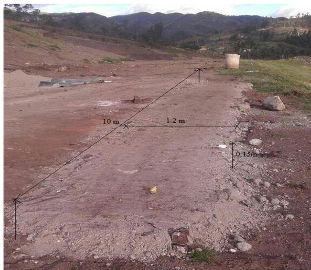
Figura 5.23. Mezcla seleccionada aplicada en campo como caminera
