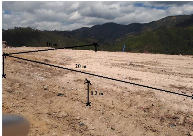
Figura 5.21. Capa de cobertura aplicada en la prueba de campo.
