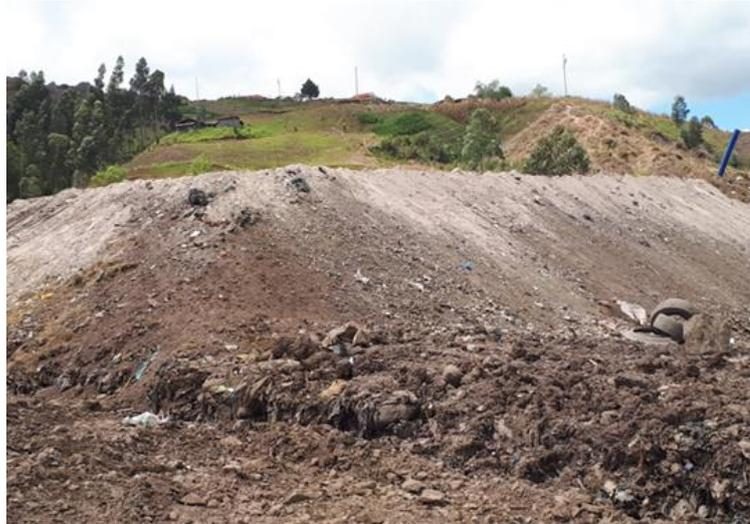
Figura 5.22. Capa de cobertura colocada en talud.
