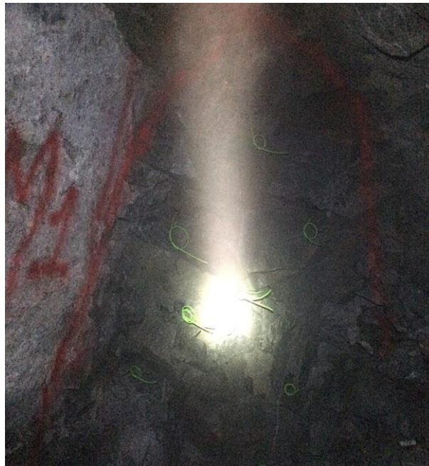
Figura 1.17: Medición para determinar el avance por voladura en la actual malla de perforación.
