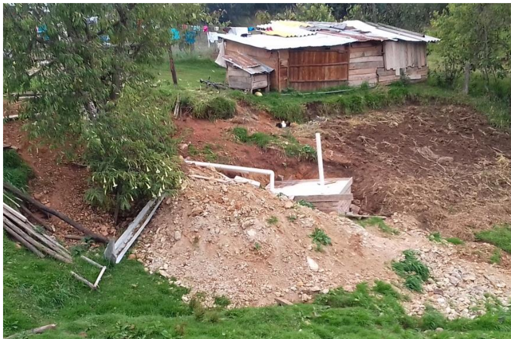
Figura 1.1.16 Construcción de nuevos pozos sépticos.
