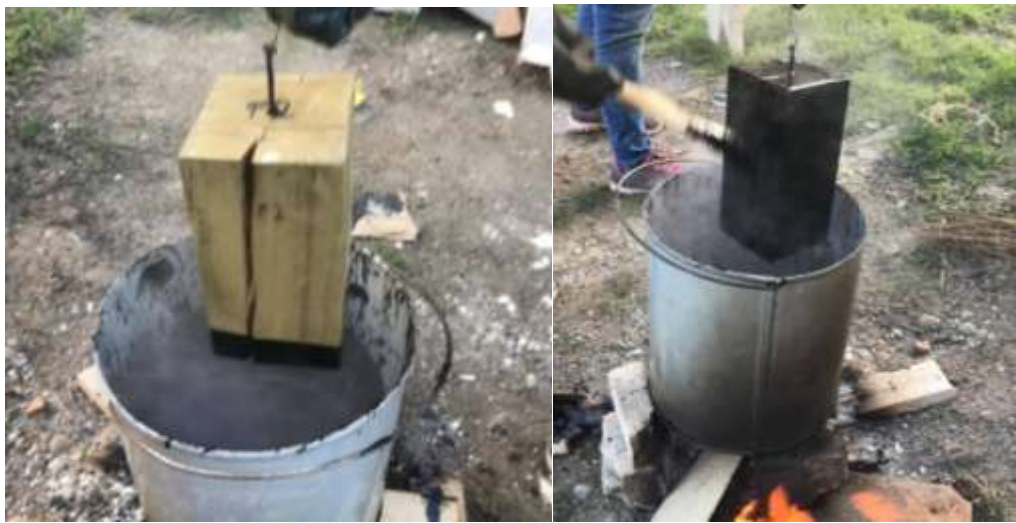
Figura 2.25 Impermeabilización de la madera con brea.
