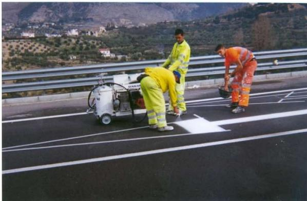
Figura 1.1. Señalización horizontal
