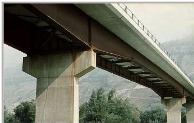
Figura 2.16. Puente de tramo continuo de sección variable
