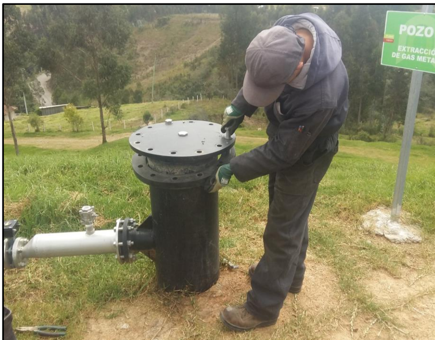
Figura 0.29. Cierre del pozo de biogás
