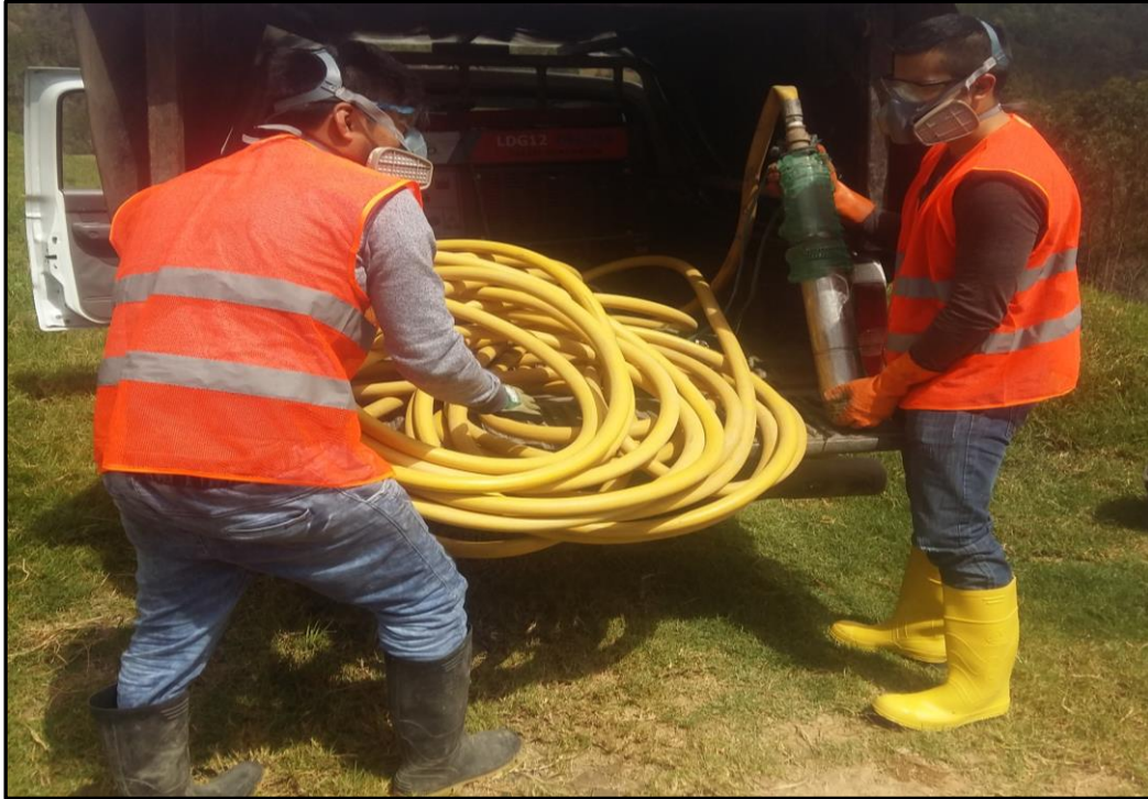
Figura 0.27. Colocación de la bomba en el pozo de biogás.
