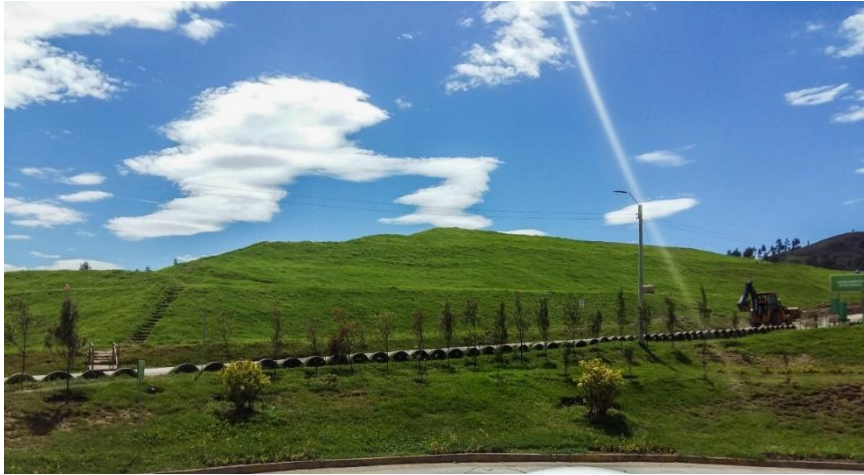
Figura 1.3. Relleno sanitario de Pichacay – fase norte I.
