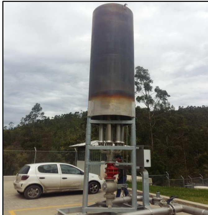
Figura 0.34. Quemador de gas.
