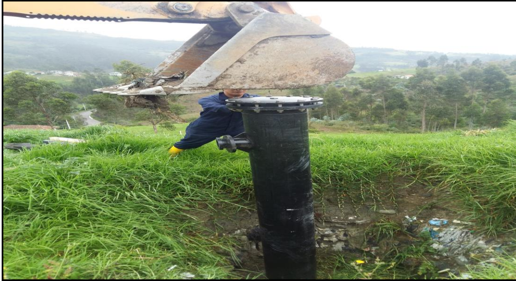
Figura 0.5. Colocación de la cabeza del pozo sobre el tubo de 160mm.
