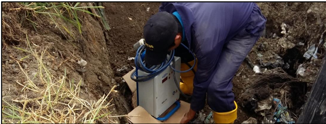
Figura 0.17. Generador a diésel utilizado para la maquina soldadora.
