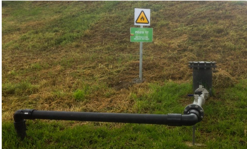
Figura 1.10. Pozo 17 – fase norte I.
