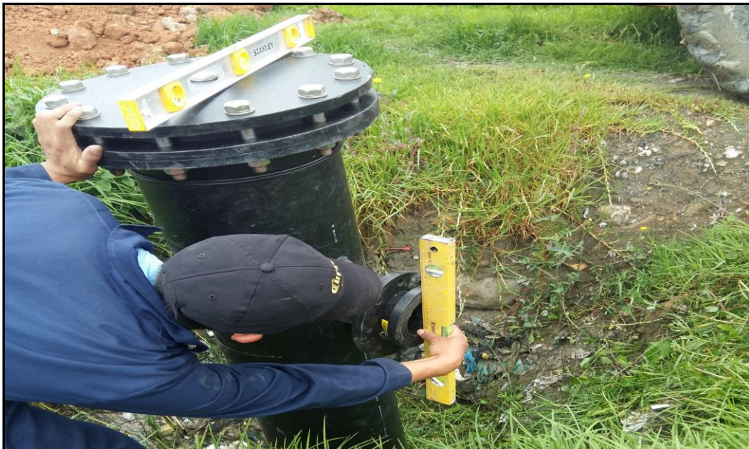
Figura 0.6. Verificación, de la correcta colocación, de la cabeza de pozo mediante niveles.
