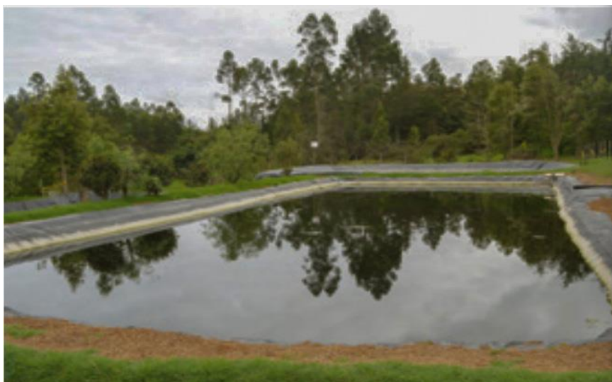
Figura 1.4. Piscinas para la recolección de lixiviados.
