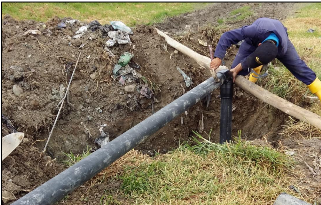
Figura 0.14. Unión de la tubería de acero inoxidable AISI 304 a la tubería conectada a la línea principal.
