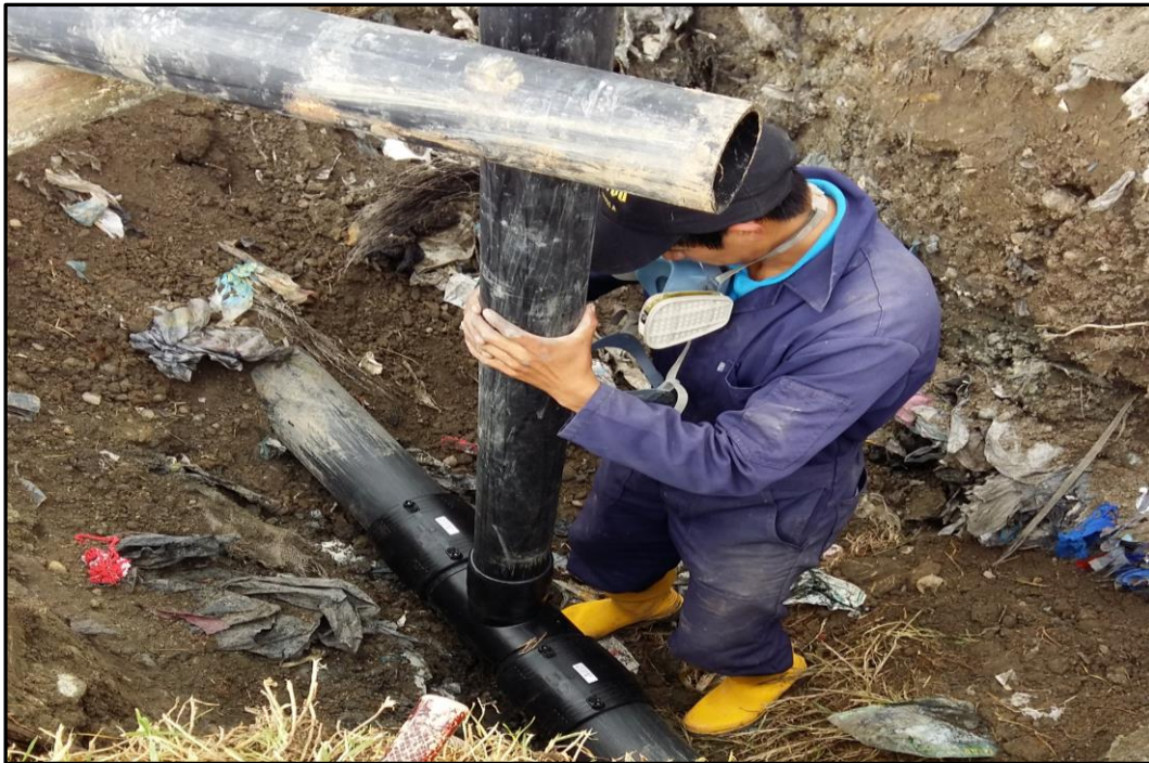
Figura 0.14. Unión de la tubería de acero inoxidable AISI 304 a la tubería conectada a la línea principal.
