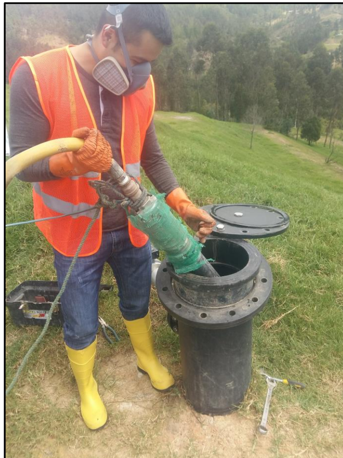
Figura 0.27. Colocación de la bomba en el pozo de biogás.
