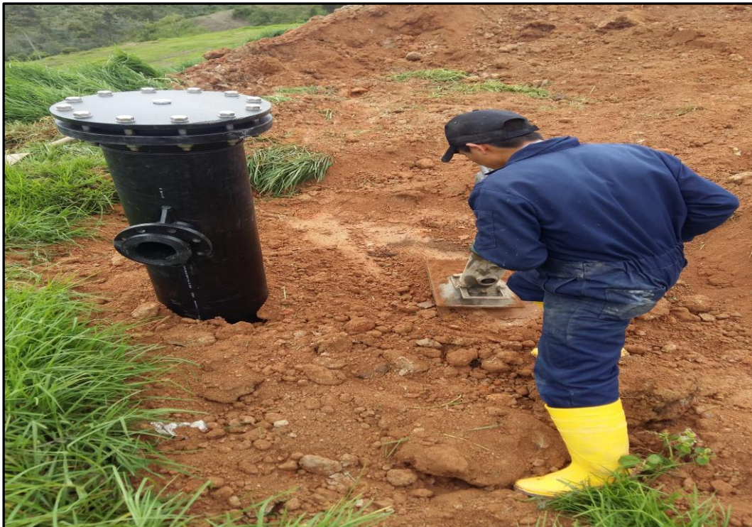
Figura 0.8. Término de la compactación mediante apisonador.
