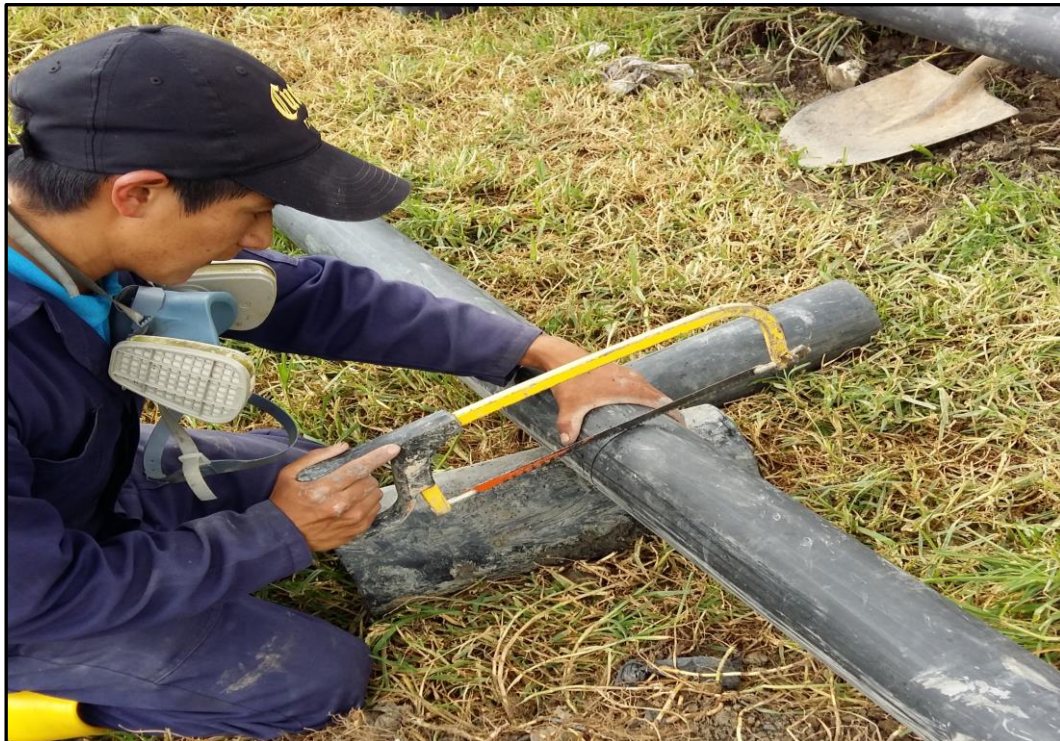
Figura 0.12. Cortes realizados en la tubería.
