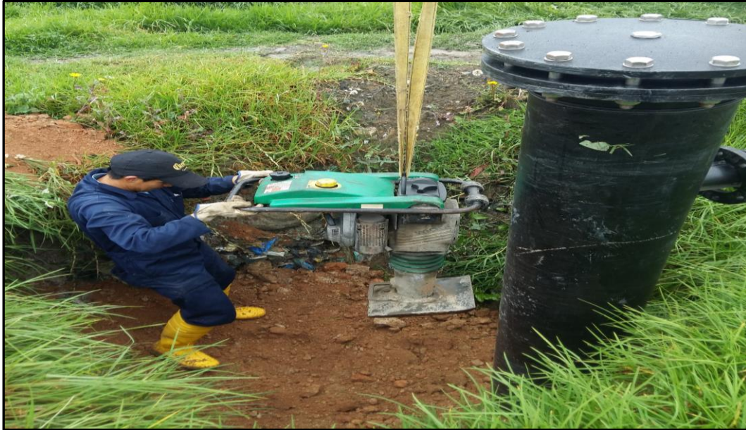
Figura 0.8. Término de la compactación mediante apisonador.
