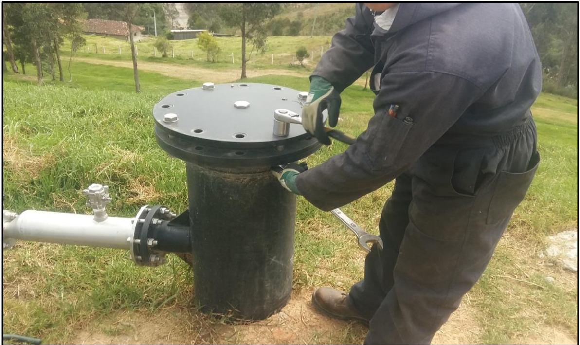
Figura 0.23. Mediante el juego de llaves destapamos el pozo de biogás.
