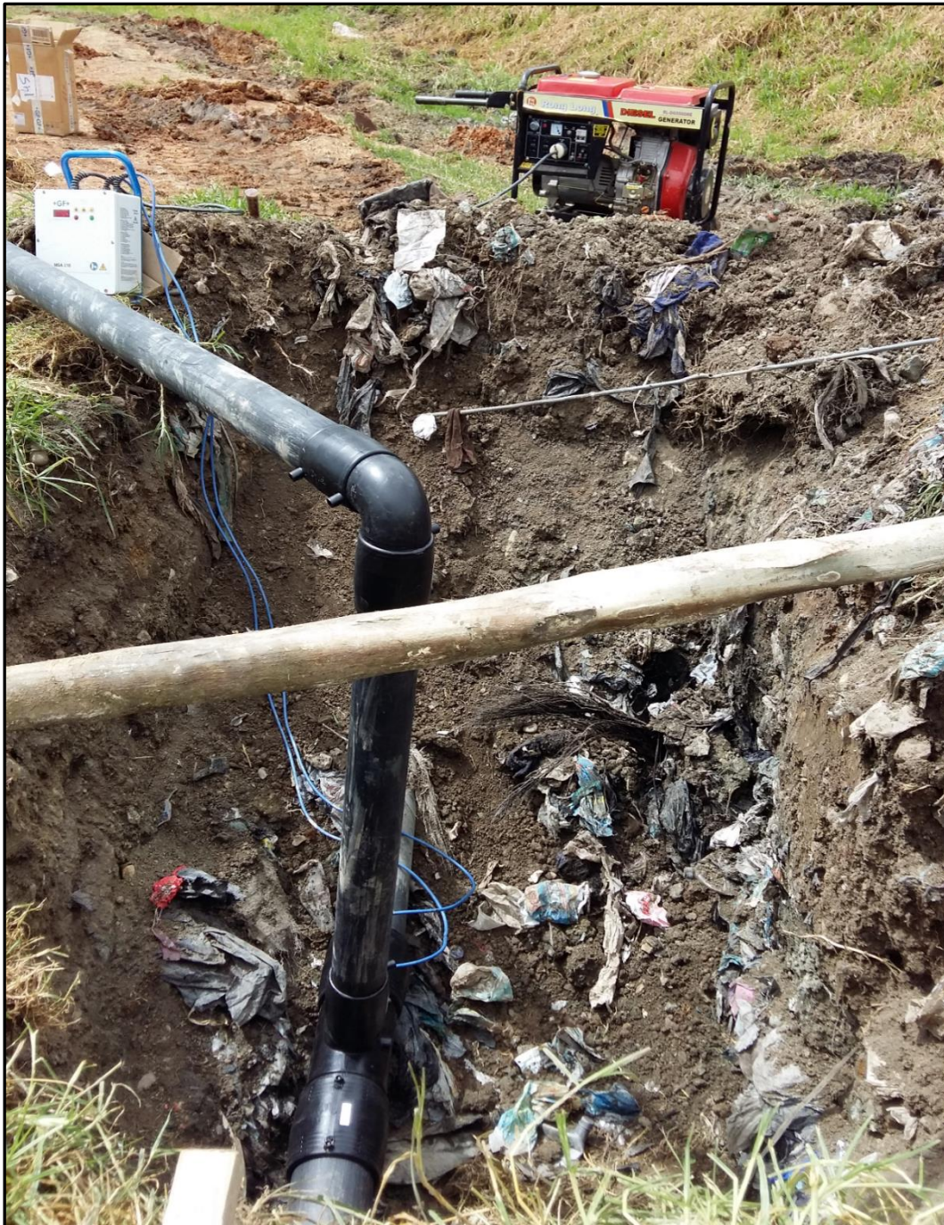
Figura 0.18. Aplicación de la maquina soldadora mediante electrofusión.
