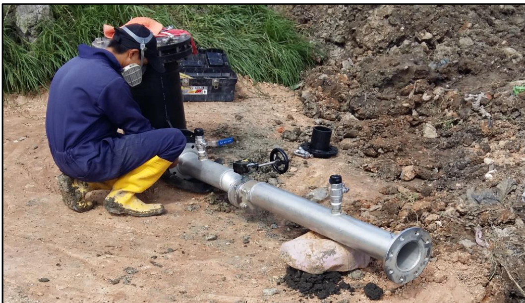
Figura 0.10. Conexión de la tubería de acero inoxidable AISI 304 a la cabeza del pozo.
