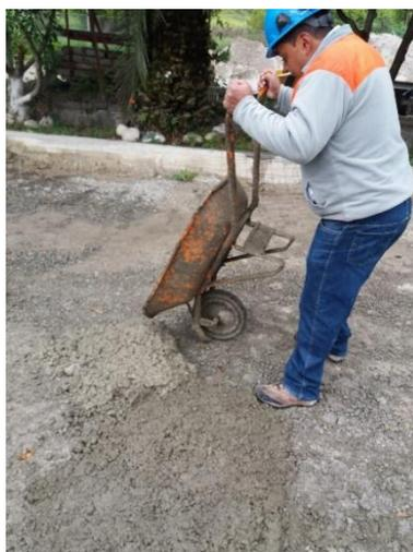
*Figura 30: Excedente de hormigón utilizado para mejoramiento de vía.*
