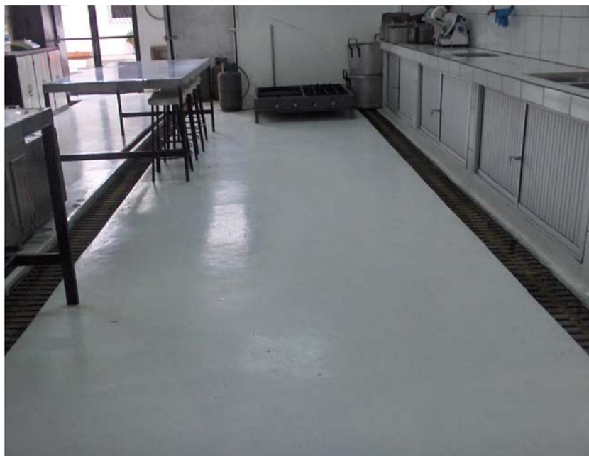
Piso recubierto con pintura epóxica apta para alimentos
