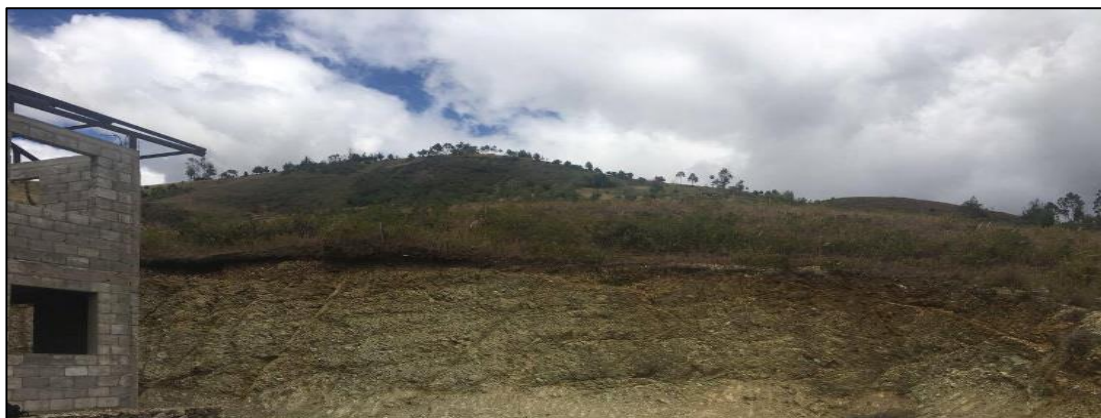
Figura 1.6: Corte en el terreno para prospección y caracterización del material.
