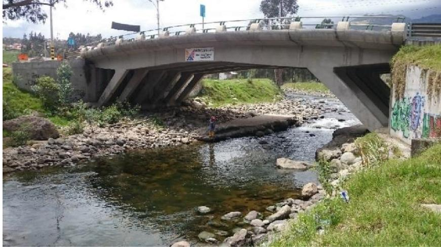
Figura 2.9. Evidencia de elementos bajo el puente Misicata que limitan el paso continuo del fluido.
