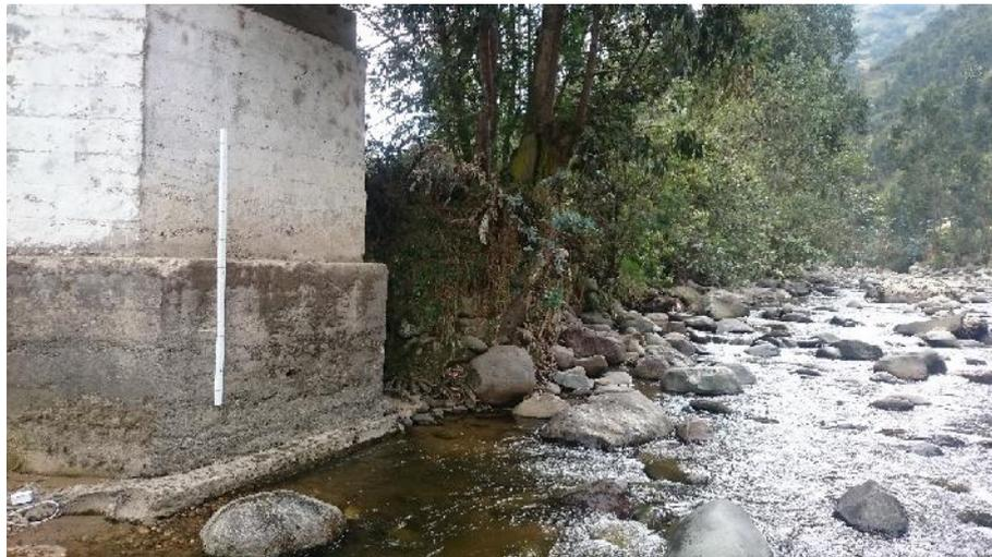
Figura 2.3. Implantación de la regleta para punto de control aguas arriba en el puente Barabón.
