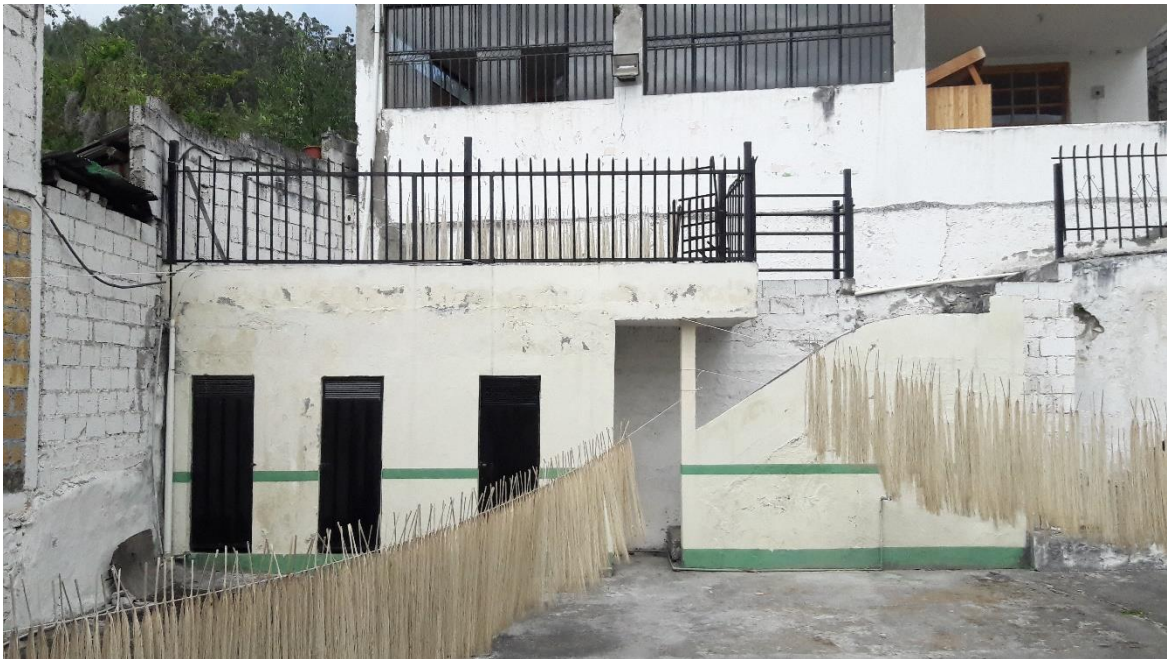
Ilustración 37: Patio trasero de la cooperativa (antes) III
