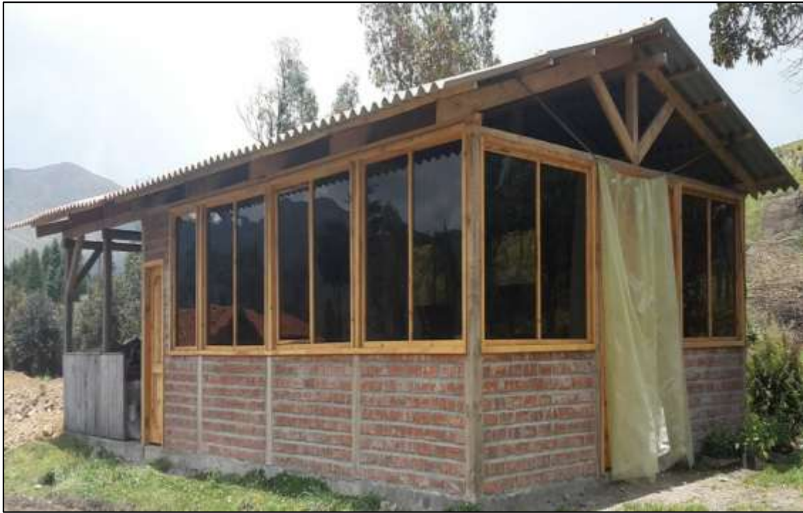
Ilustración 24 Vista Lateral Centro de Interpretación
