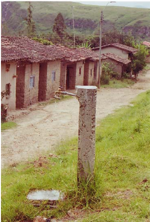
Toma de Agua en una de las esquinas del parque
