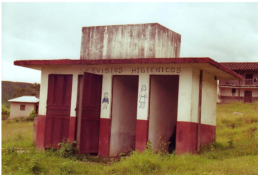
Servicios Higiénicos ubicados en el parque de la comunidad
