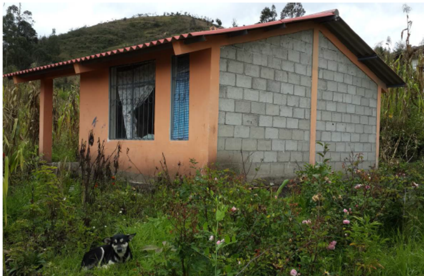
Figura 1 5 Vivienda Social MIDUVI (exterior)
