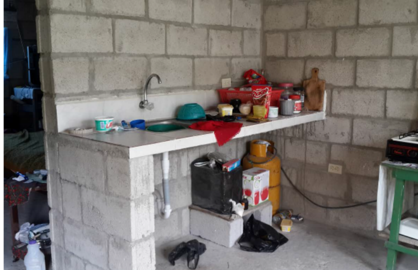
Figura 1 4 VIVIENDA MIDUVI (cocina)
