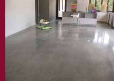
Figura 73: Hormigón pulido
