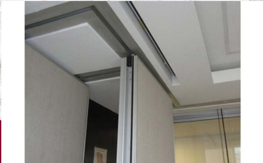
Figura 55: Rieles de paneles flexibles
