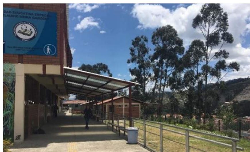
Ilustración 56. Espacio actual: Corredores Fuente: De elaboración propia
