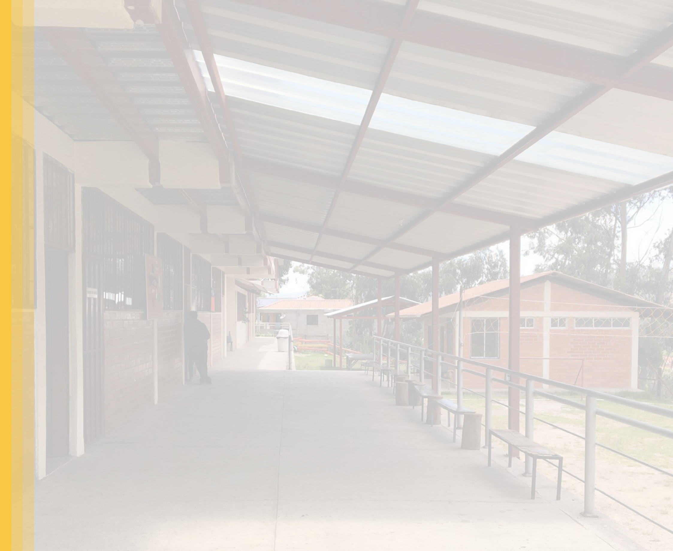
Ilustración 90. Pasillo principal estado actual Fuente: De elaboración propia
