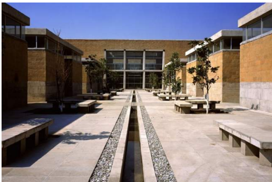
Ilustración 12. Patio exterior Fuente: (Gordoa, 2000)
