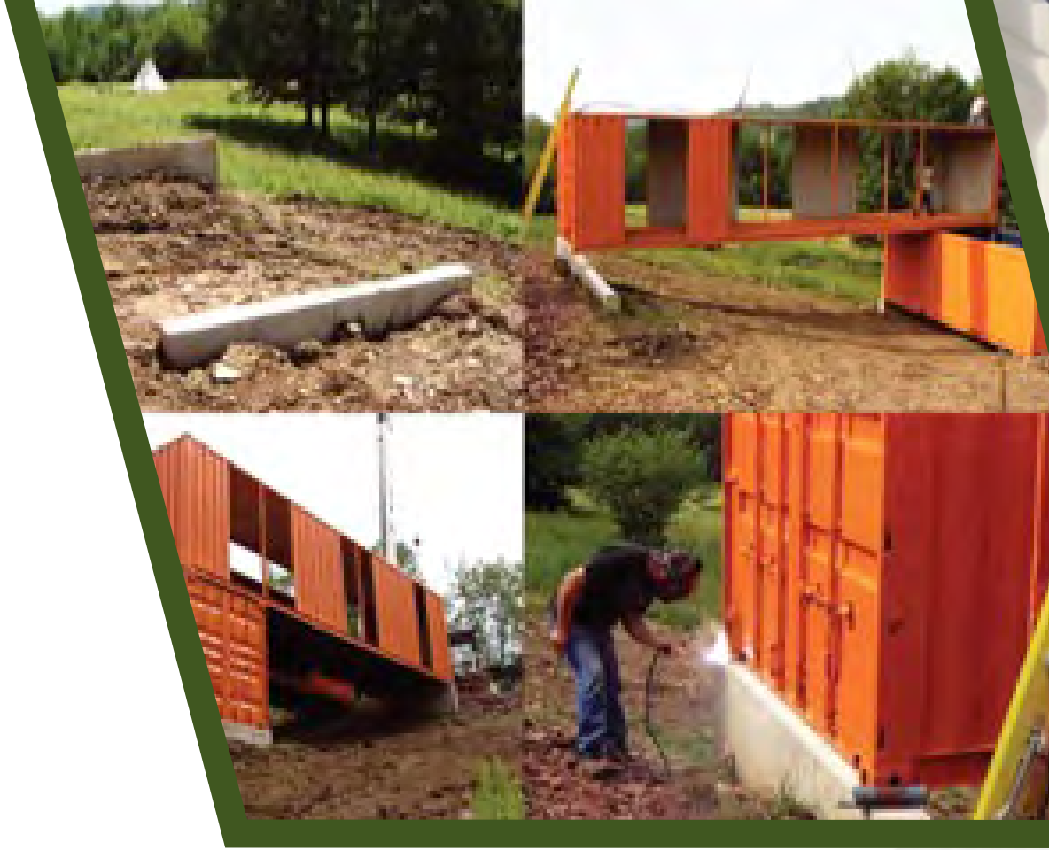
Figura 42: Cimentación de un contenedor
