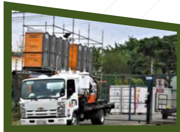
Figura 47: Instalaciones Facilidades técnicas S.C
