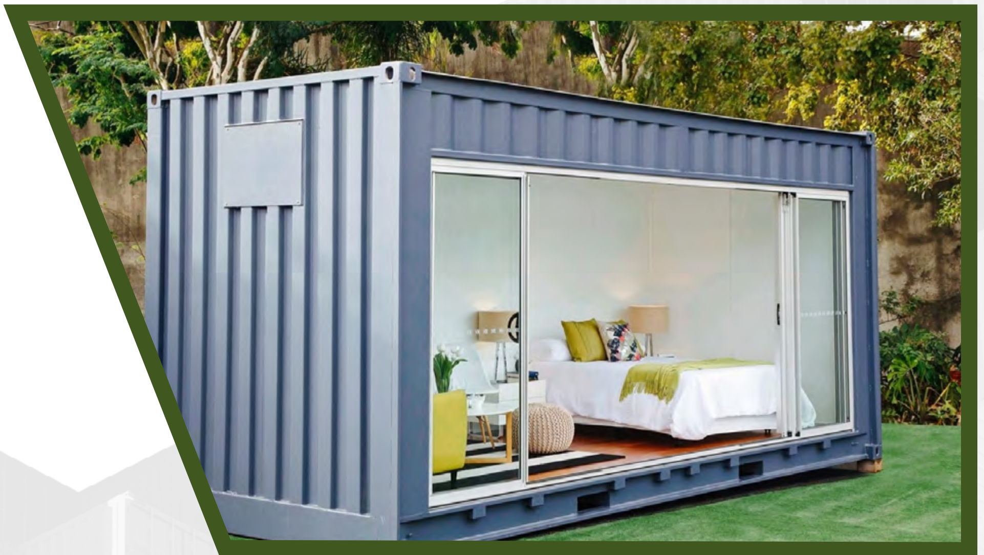
Figura 39: Casa prefabricada en contenedores.
