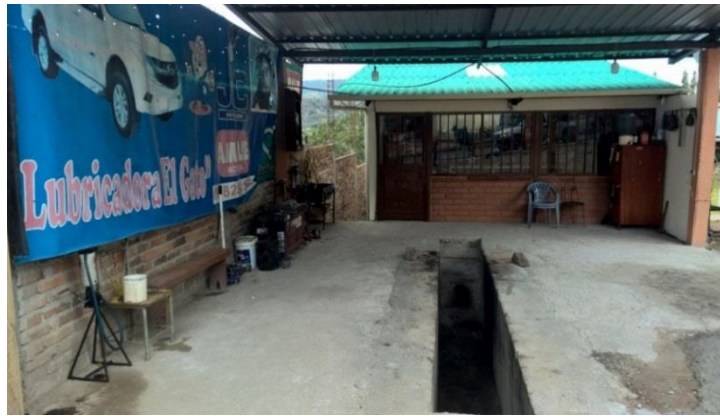
Figura 2.7: Fosa para cambios de aceite con salida residuales al alcantarillado de la lubricadora Señor de los Milagros.
