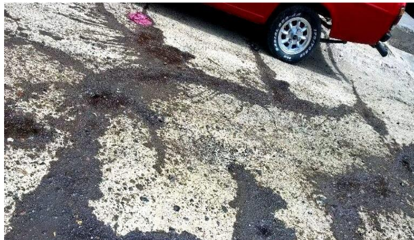
Figura 1.2: Aceite derramado sobre caminos de tierra en el Cantón Nabón para evitar el polvo.
