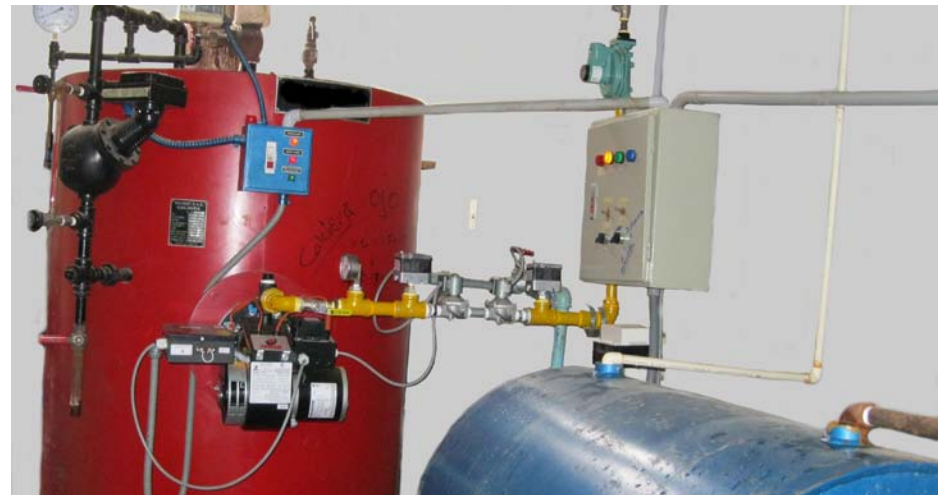
Figura 28. Caldera de vapor (HORNOS HINRA S.A., s.f.).
