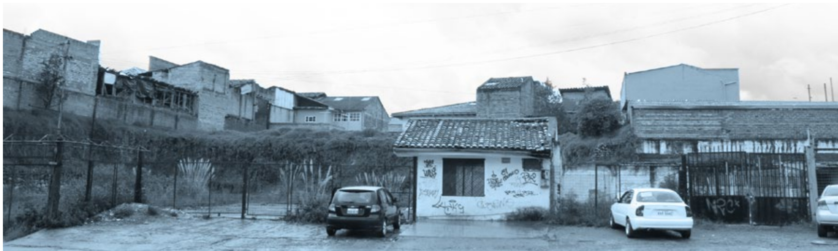
Imagen 64. Estado actual de zona de intervención.
