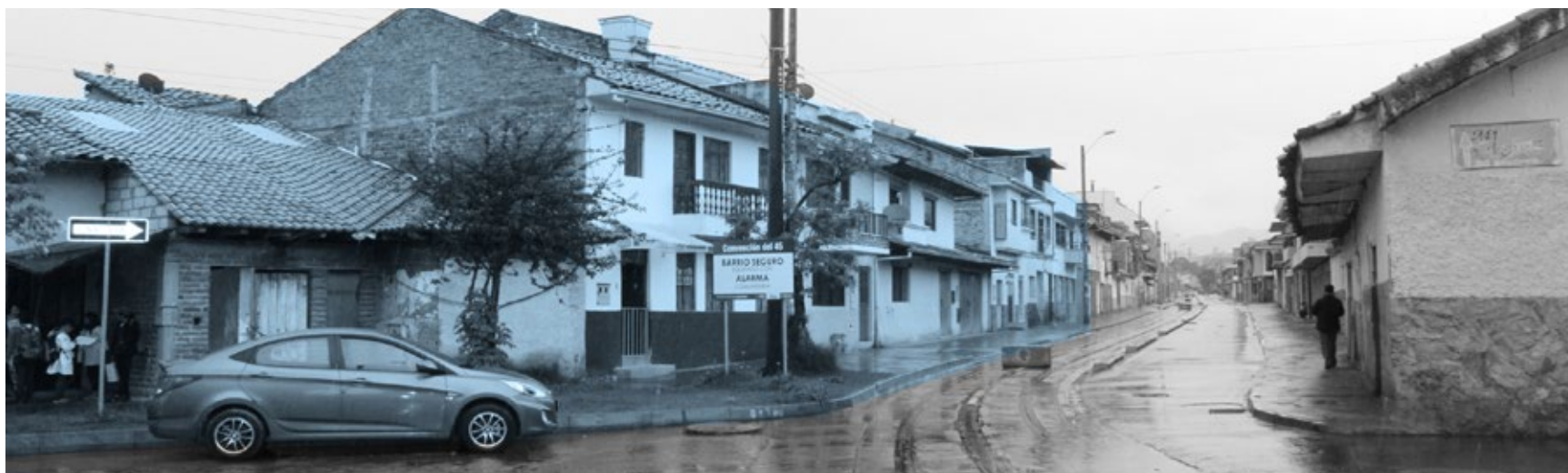
Imagen 68. Estado actual, vista desde calle Mariscal Lamar.
