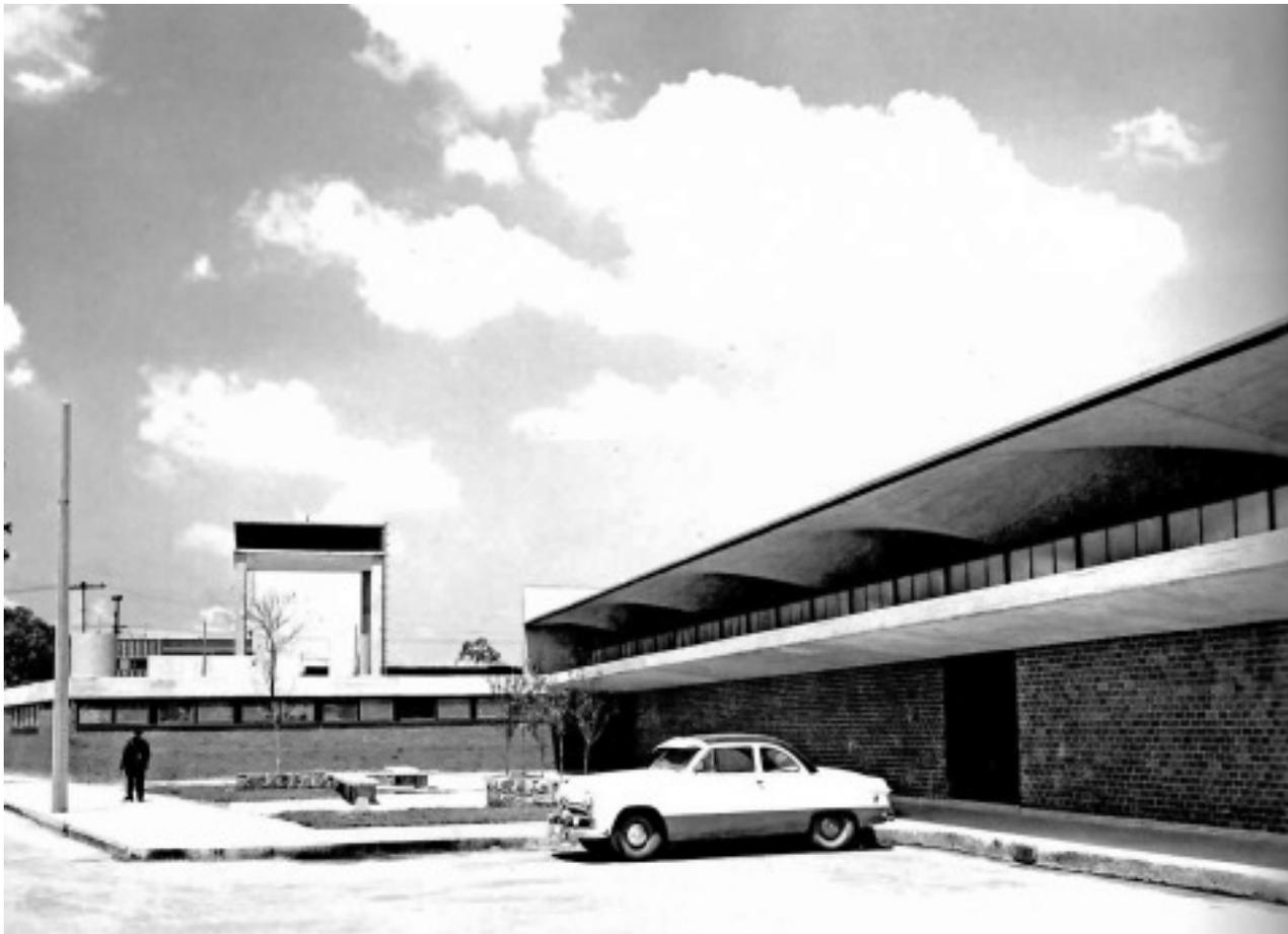
Lo más representativo del proyecto es su estructura, consiste en una serie de paraboloides hiperbólicos, contruidos de hormigón ligero de aproximadamente 6.5m de altura, un extremo más alto que otro. Así, la parte alta de la estructura cubre la parte baja del siguiente, y como conjunto su parte superior define una línea serrada. Los espacios entre la estructura tienen ventanas para iluminar y ventilar el mercado. (Loyens, 2008)
