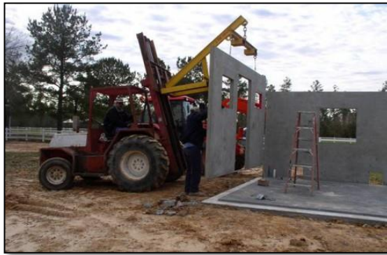
Figura 2.19. Sistema semi-prefabricado con paneles de hormigón.
