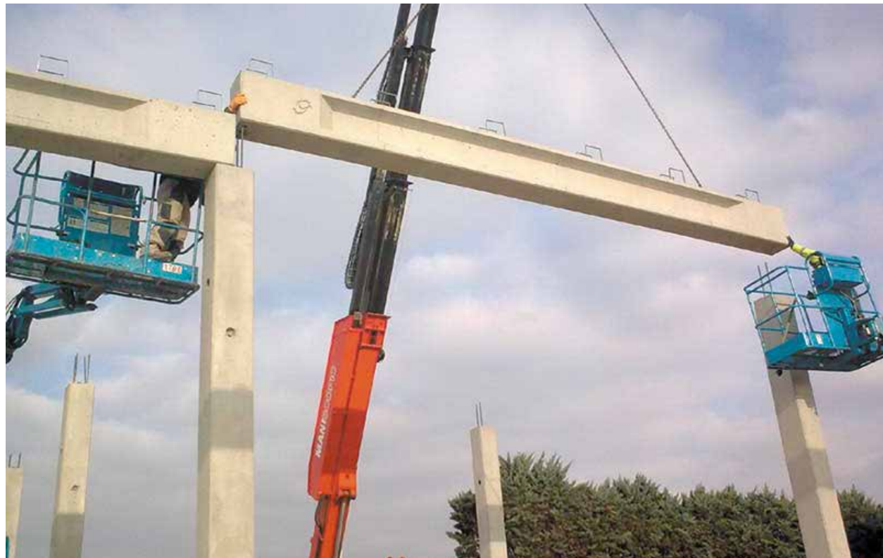
Imagen 26. Colocación de vigas prefabricadas Fuente: http://www.mabeton.com/archivos_web/image070.jpg
