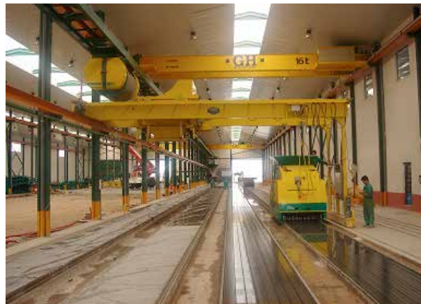
Imagen 23. Procedimiento de tensado
