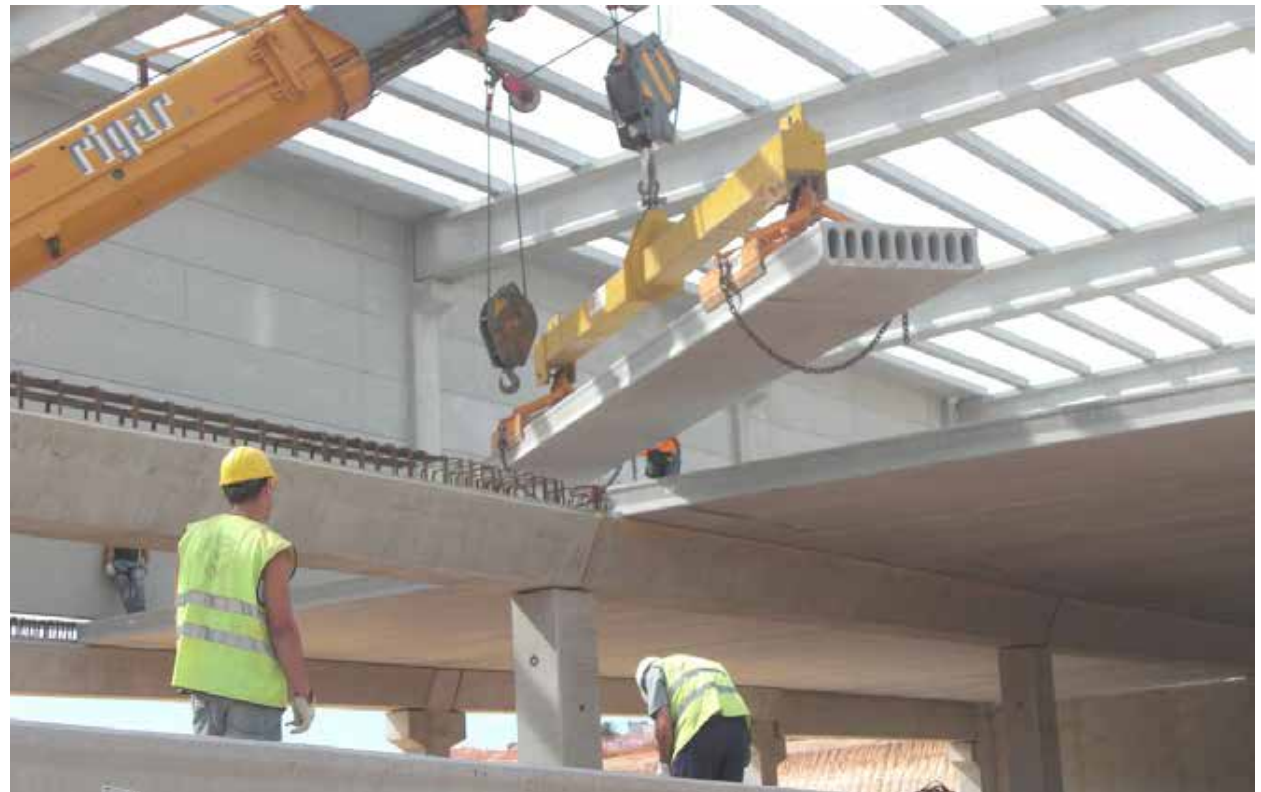
Imagen 27. Montaje de elementos prefabricados
