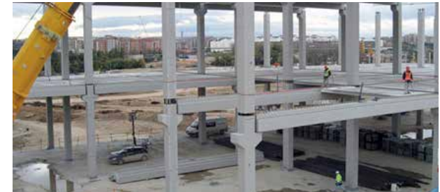
Imagen 18. Estructura de columnas y vigas pretensadas Fuente: http://www.lineaprevencion.com/ProjectMiniSites/IS35/
