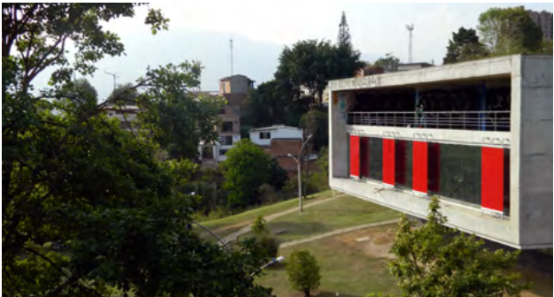
Imagen 1: Medellín - Fuente: Propia Imagen 2: Parque biblioteca La Ladera - Medellín - Fuente: Propia
