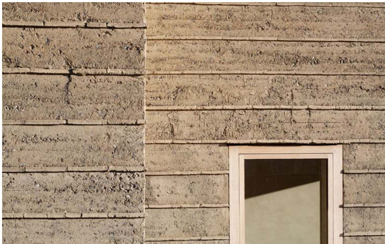
44. Casa Rauch - Schlins, Austria Fuente: https://goo.gl/pUQPFH
