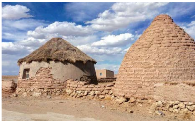
25. Vivienda vernácula - Chipaya, Bolivia Fuente: https://goo.gl/BSZZ2u
