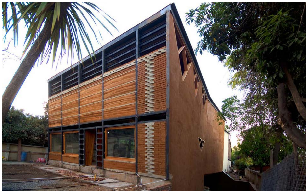
42. Centro de ecología aplicada - Santiago de Chile, Chile Fuente: https://goo.gl/xpw57g
