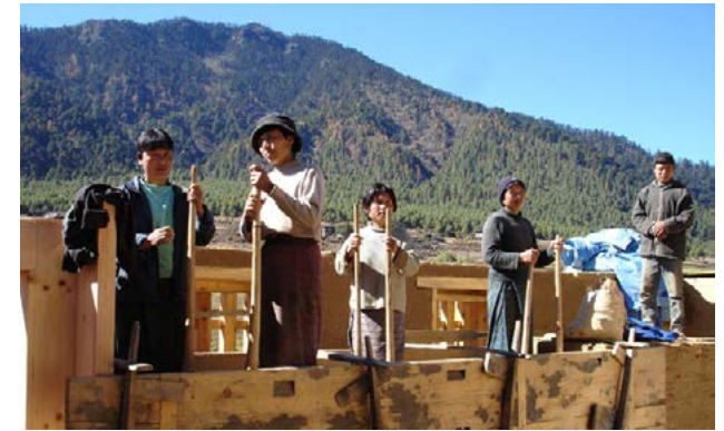
26. Técnica de apisonado para muro de tapial - Buthan, Sri Lanka Fuente: https://goo.gl/WPmZyV
