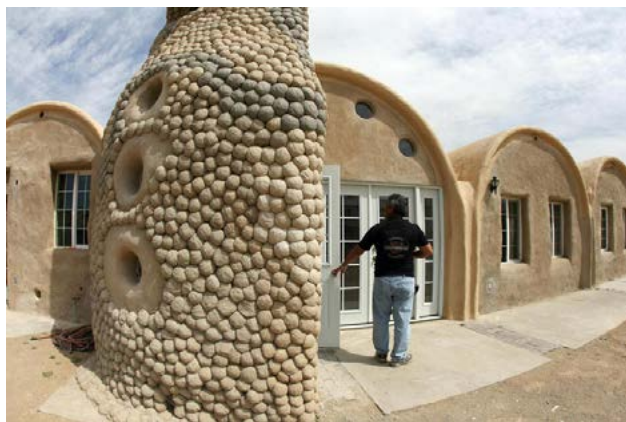
31. Técnica COB en viviendas Fuente: https://goo.gl/8SsQYW
