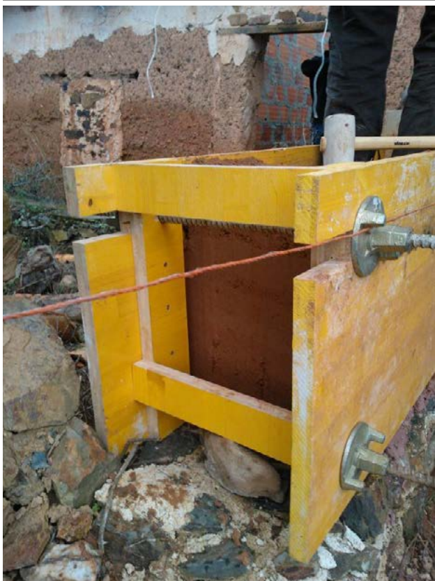
35. Prueba de encofrado, ARQ21.ATELIER Fuente: https://goo.gl/yECq5j
