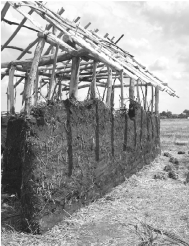
03. Proceso de construcción de una vivienda, Vadastra Fuente: (Creanga, Ciotoiu, Gheorghiu, & Nash, 2010, pág. 166)
