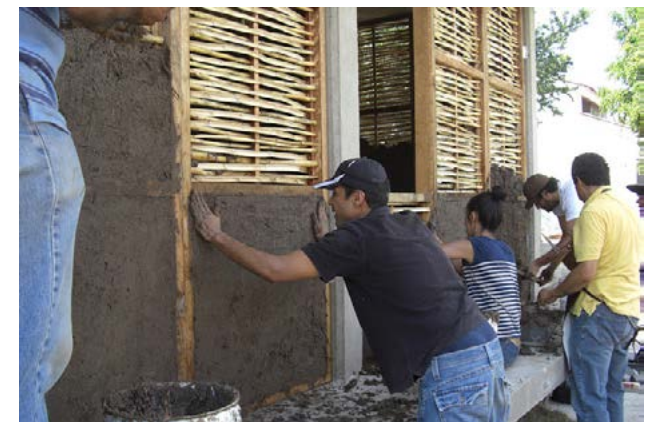
33. Técnica de revoque con tierra Fuente: https://goo.gl/xYUXWd
