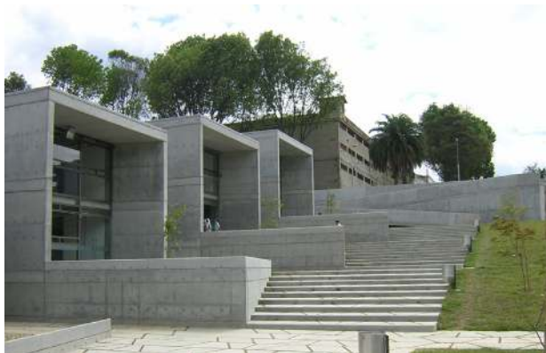
IMG. 24 Acceso lateral, escalera pública.
