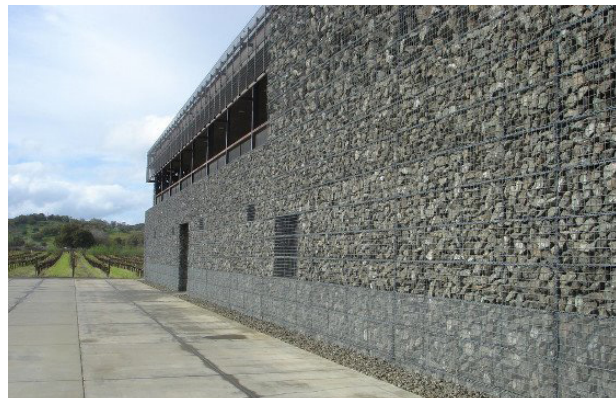
IMG. 28 Vista exterior, materialidad gaviones de piedra.
