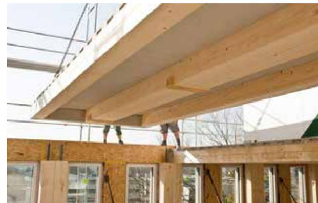
imagen 27 Sistema de anclaje losas con fachada
