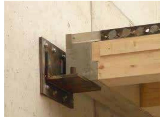
imagen 23 detalle de unión Losa con estructura de hormigón armado
