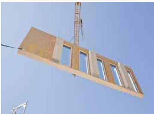
imagen 26 modulo de fachada prefabricada de One life cycle tower
