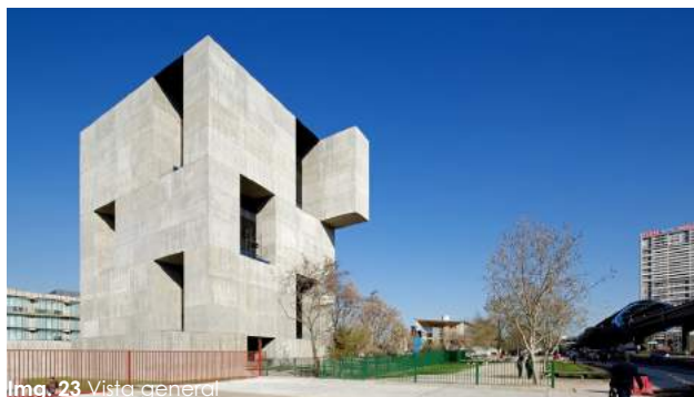
Img. 23 Vista general
