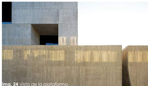
Img. 24 Vista de la plataforma
