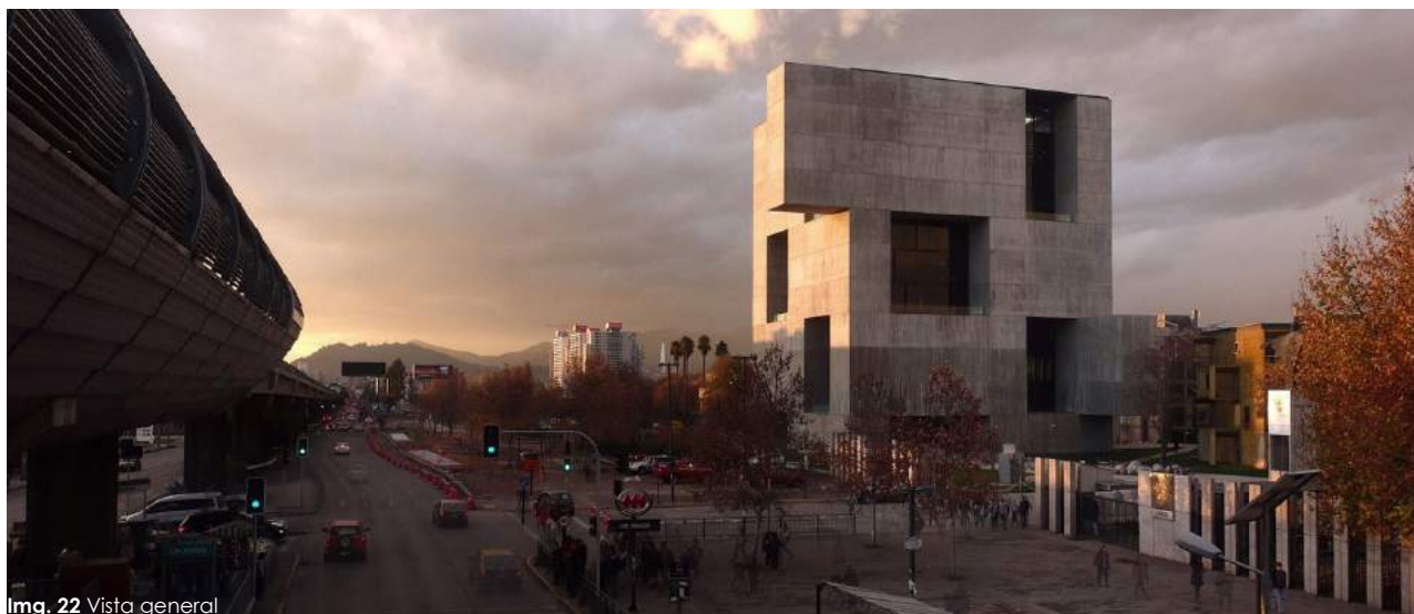
Img. 22 Vista general
