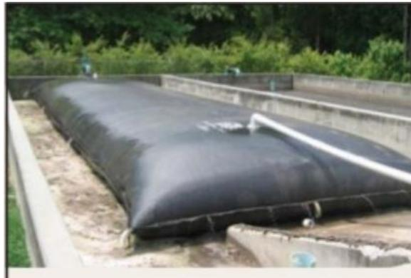
Figura 2.30. Llenado de GeoTube.
