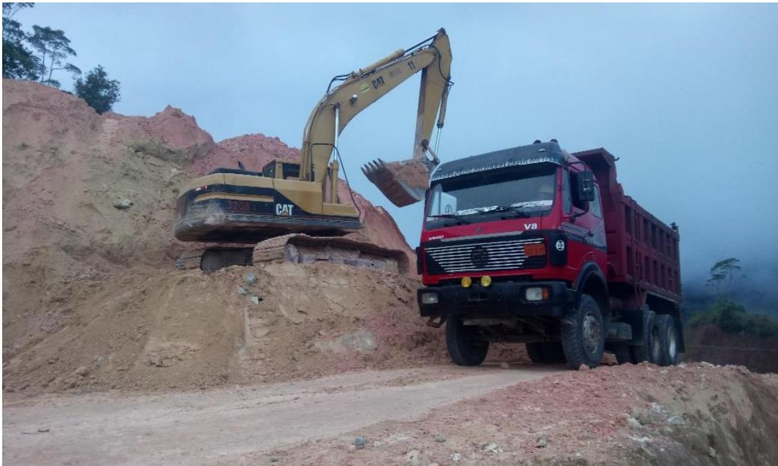
Figura 1.17: Carga de material de destape
