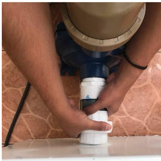
Figura 3.1: Ajuste de la unión universal.
