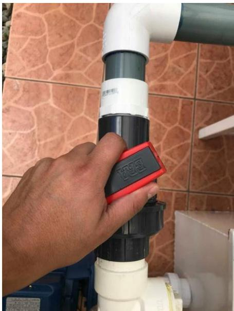
Figura 3.9: Abrir la llave del sistema de recirculación.
