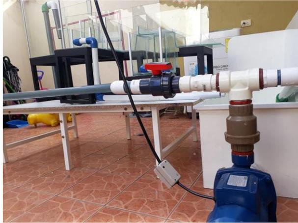
Figura 2.39 Instalación del sistema de recirculación del agua.
