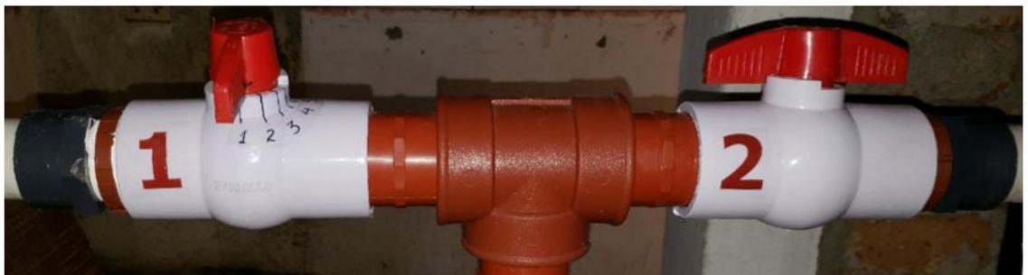
Figura 3.14 Válvula 1 cerrada en posición 1 y válvula 2 abierta (posición fija)
