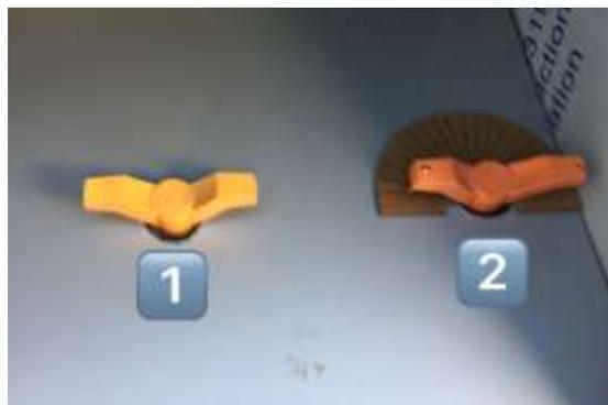
**Figura 3.39** Abertura de las válvulas de paso
