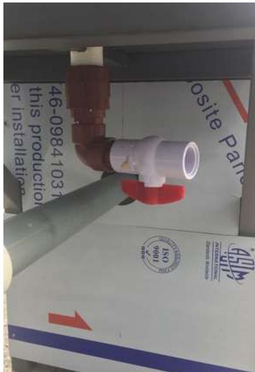
**Figura 10:** Válvula de desfogue
