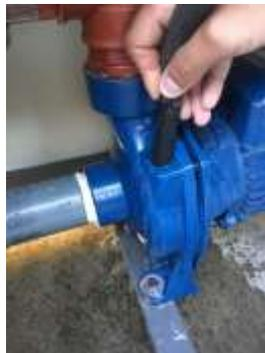
**Figura 3.53** Llenado de agua en la cámara de la bomba
