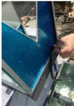
**Figura 3.47** Colocación de la tira de caucho
