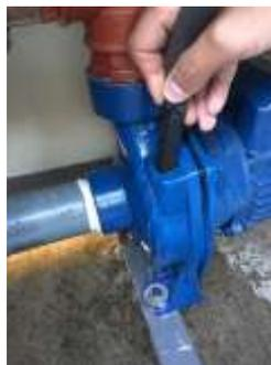
**Figura 3.11** Llenado de agua en la cámara de la bomba
