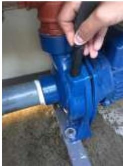
**Figura 3.32** Llenado de agua en la cámara de la bomba
