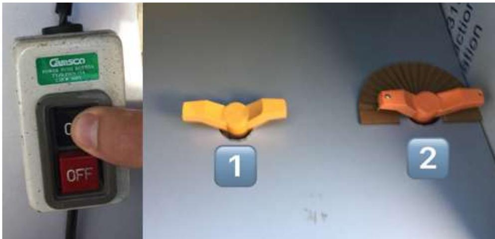
**Figura 3.55** Encendido de la bomba, con las válvulas de paso abiertas
