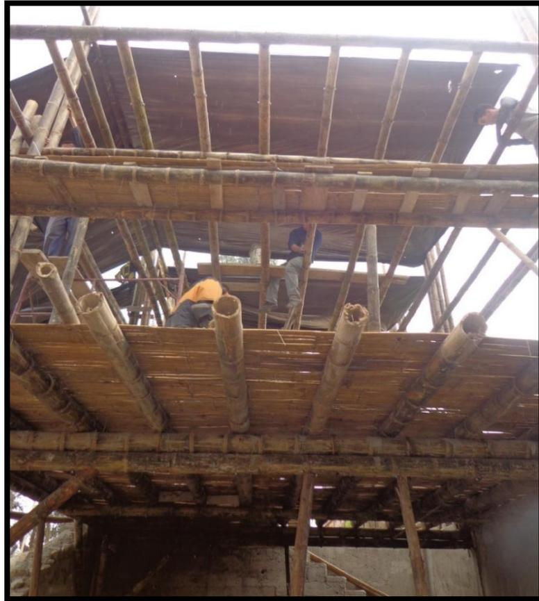
*Figura 2.3. Separación entre bambú y fundición de losa*
