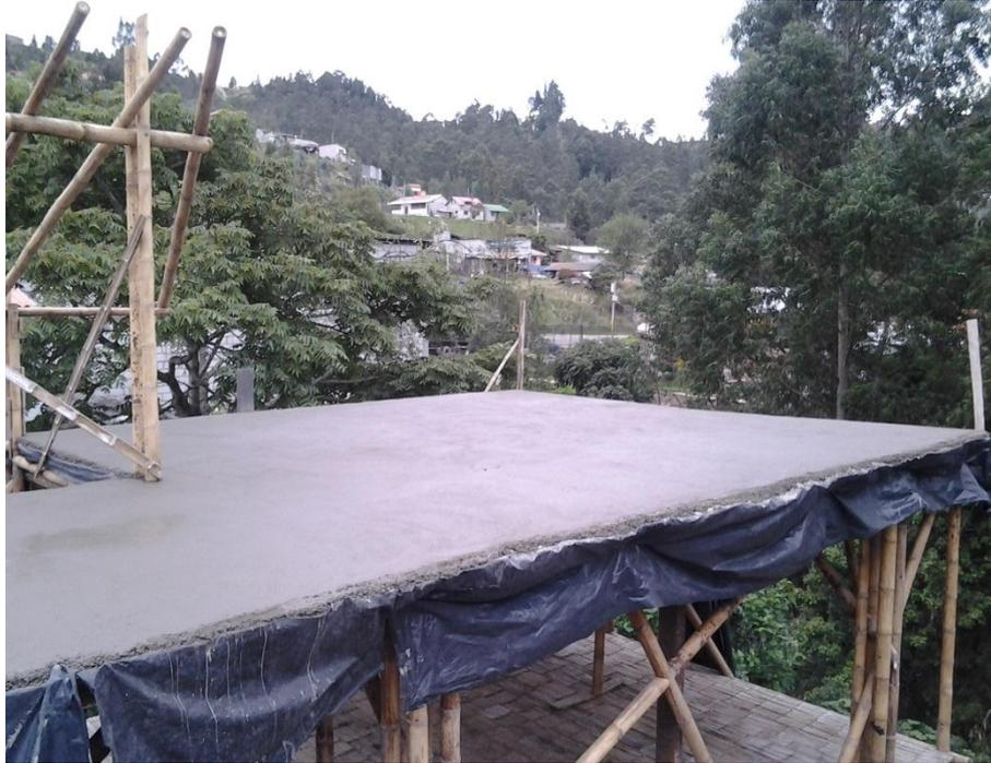
*Figura 2.4. Fundición de losa*
