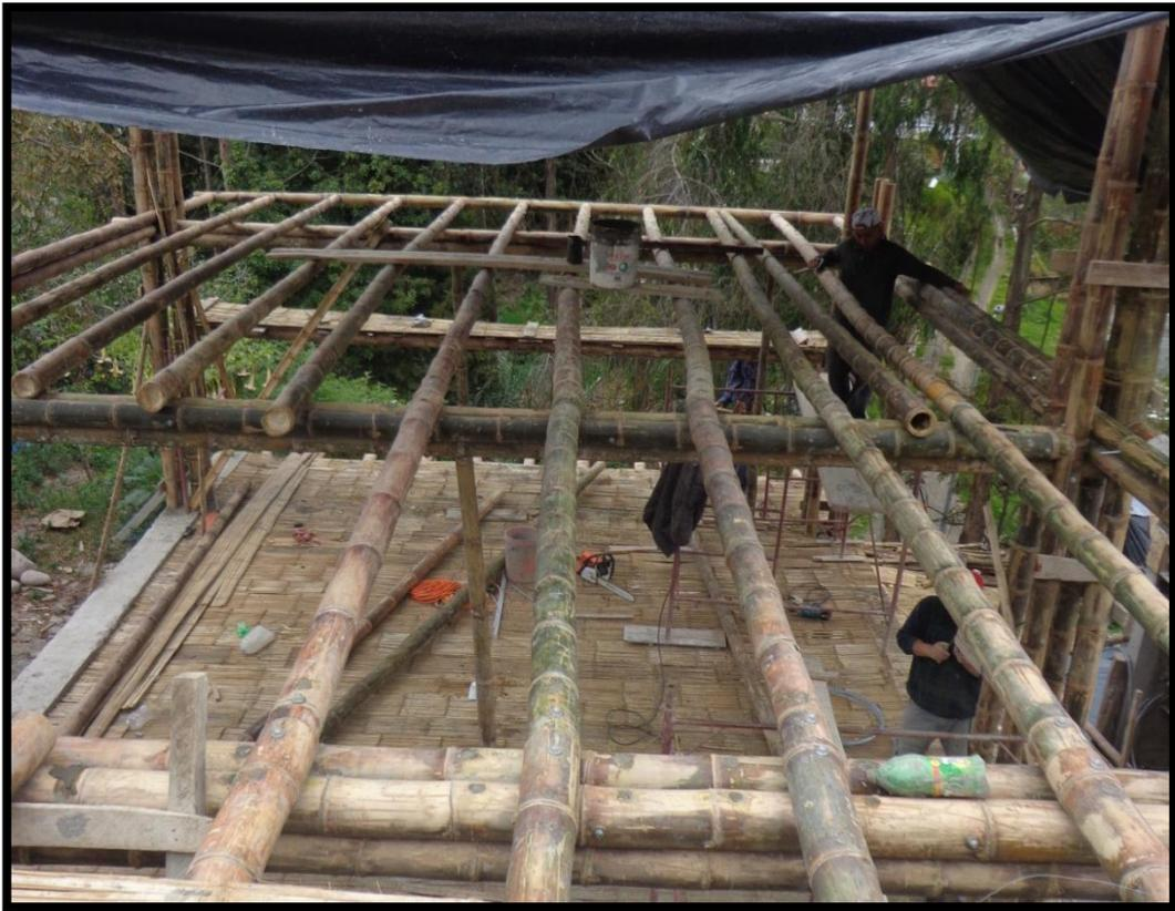
*Figura 2.6. Colocación de caña como vigas y viguetas.*
