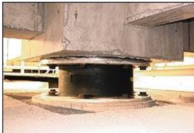
**Figura 2.14** Estructura aislada con caucho natural (NBR).
