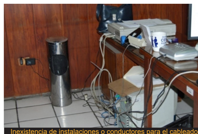
Inexistencia de instalaciones o conductores para el cableado.
