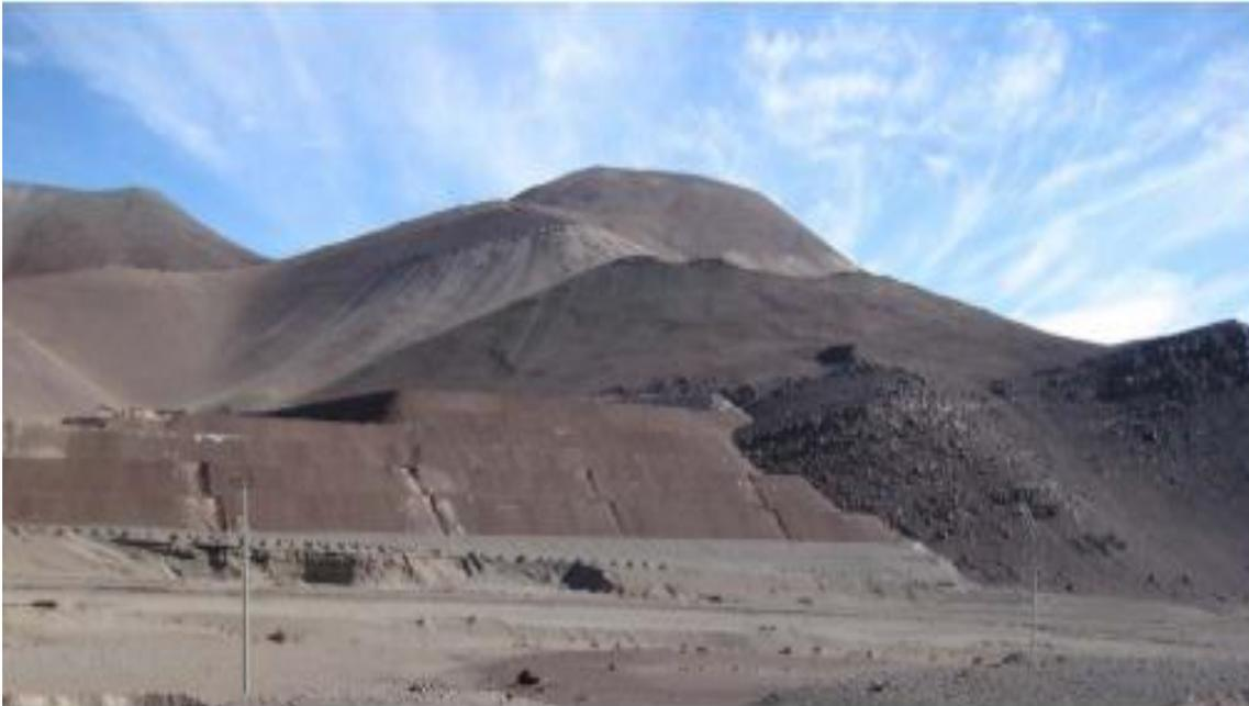
Figura 2.5. Depósito de relave Filtrado.
