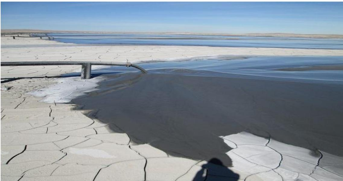
Figura 2.4. Depósito de relave Espesado.
