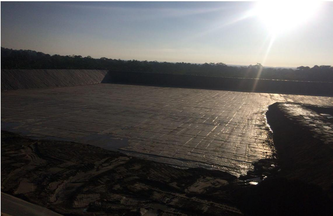
Figura 3.3. Sistema de impermeabilización de una relavera.
