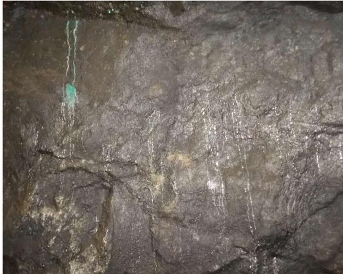
**Figura 3.2. Humedad presente en las paredes del macizo rocoso**
