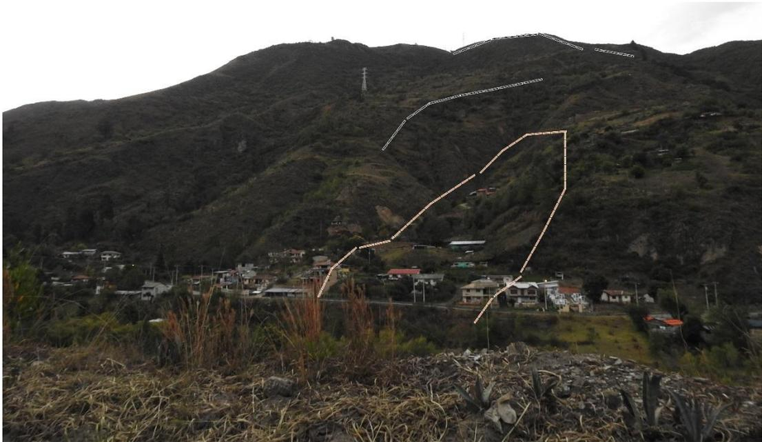
Figura 2. 24. Deslizamiento en la zona de Lugmapamba, casas construidas en la zona de deslizamiento.
