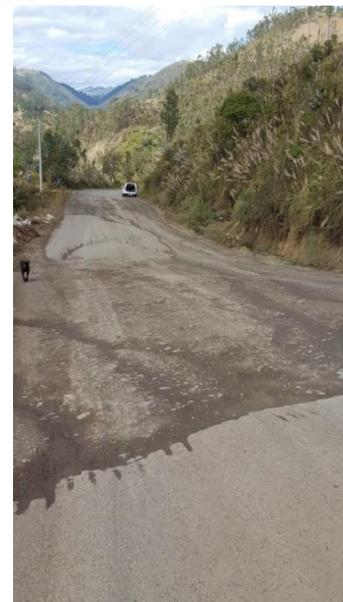
**Figura 2.36** Jadán hundimiento y desplazamiento en la vía
