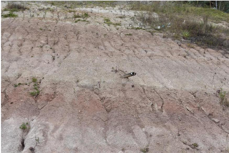
**Figura 2.4 Carmen del Guzho. Sistema de drenaje en talud**
