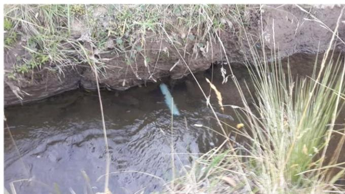
Figura 4.1 Fuga de agua en el canal de captación
