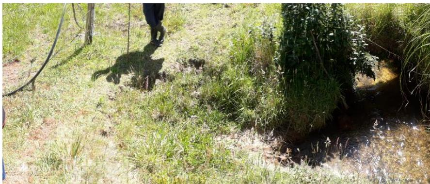
Figura 2.14 Filtraciones en el canal a causa de robos con mangueras
