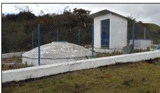
Figura 1.53. Foto reservorio de agua potable
