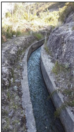
Figura 1.51. Foto canal revestido con hormigón
