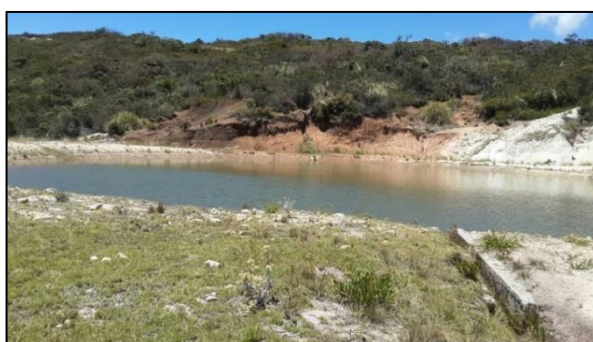
Figura 1.47. Foto reservorio San José
